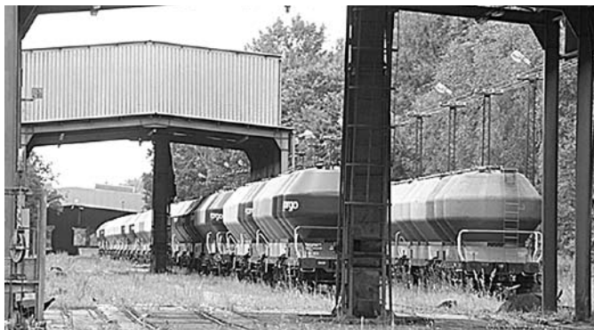
Rys. 15 Stanowiska do ładunków sypkich na Terminalu Kowalewo
