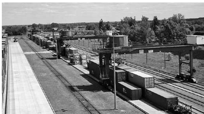
Rys. 7 Front przeladunkowy suwnic szynowych
