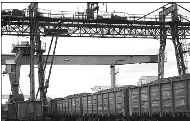
(Rys. 4) Suwnice szynowe do przeladunku towarów masowych
